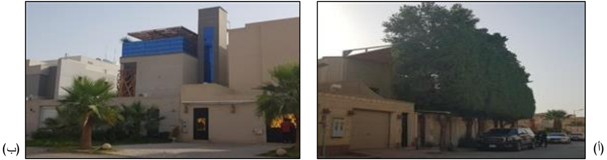
شكل ٨. بعض الحالات المرصودة داخل الحي المعاصر (الصحافة) لرفع الخصوصية داخل ارتداد المنزل، ففي الشكل (أ) نجد أن صاحب المنزل لجأ إلى استخدام ارتفاع الأشجار والمظلة لتأمين الارتداد، أما الشكل (ب) نجد أنه لجأ إلى استخدام السطح كمتنفس عوضاً عن الارتداد.
