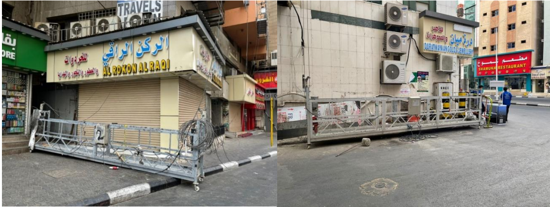
شكل ٦. استعمال سقالات تنظيف وإجهات الفنادق الخارجية خلال موسم الحج.
