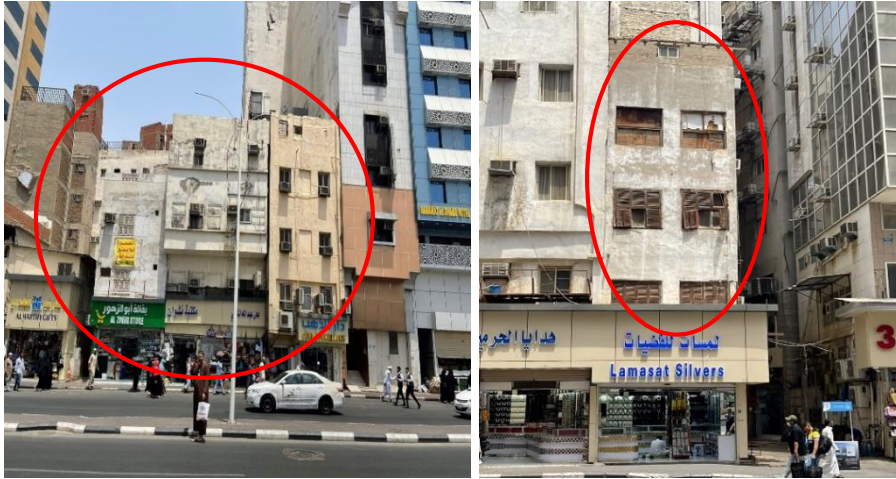
شكل ٤. ظاهرة وجود مباني قديمة متهاكّة وآيلة للسقوط بشوارع إبراهيم الخليل.
