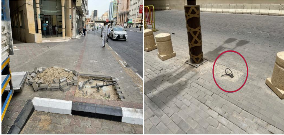
شكل ١. ظهور كوابل الكهرباء على الطرق بشارع إبراهيم الخليل.
